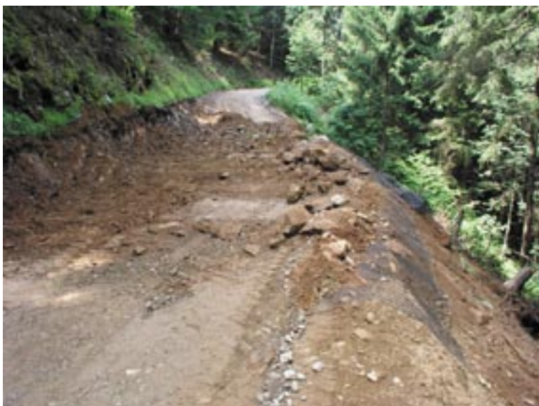
Böschungsaufbauten mit „bewehrter Erde“ bilden ein stabiles Straßenfundament.
