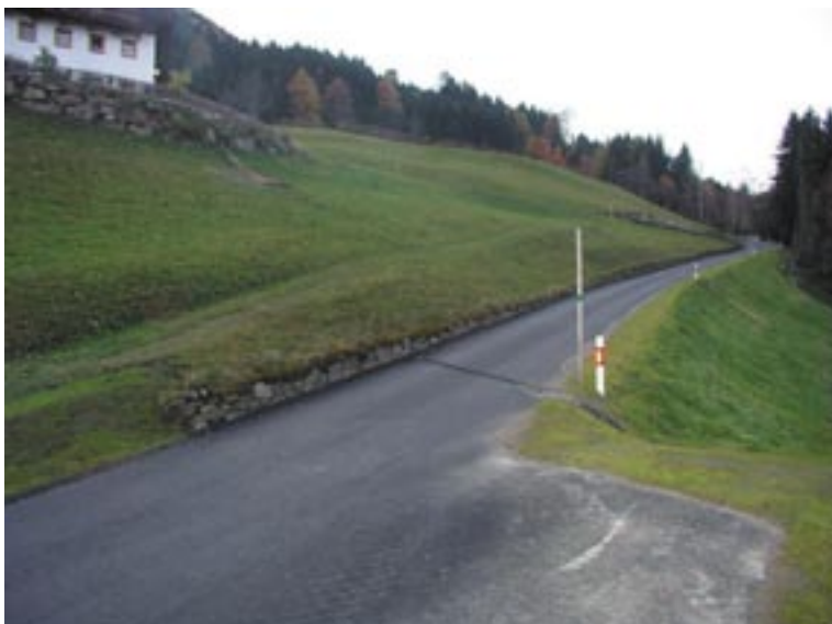
Fertig gestellte Weganlage im Bereich der „Wiese“
