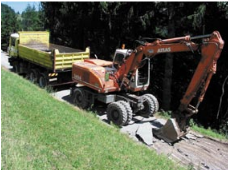
Die Ausführung der Arbeiten durch regionale Firmen und Osttiroler Güterwegarbeiter schafft Arbeitsplätze im ländlichen Raum.
