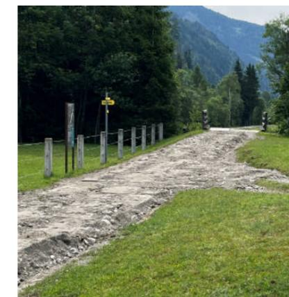
*Die Abt. Wasserwirtschaft vom Baubezirksamt Lienz führt derzeit eine Sanierung vom Uferbegleitweg am rechten Ufer der Isel durch. Die bestehende Weganlage wird maschinell gebrochen und zusätzlich wird noch eine Lage Wegschotter aufgetragen.*
