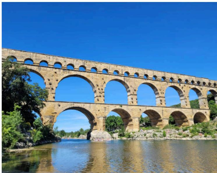
Seit fast 2000 Jahren steht der 273 m lange Pont du Gard, ganz ohne Beton - nur aus präzise behauenen Steinen errichtet.
