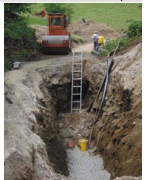
Unterquerung einer bestehenden Brücke unterhalb vom Pold - Angerer
