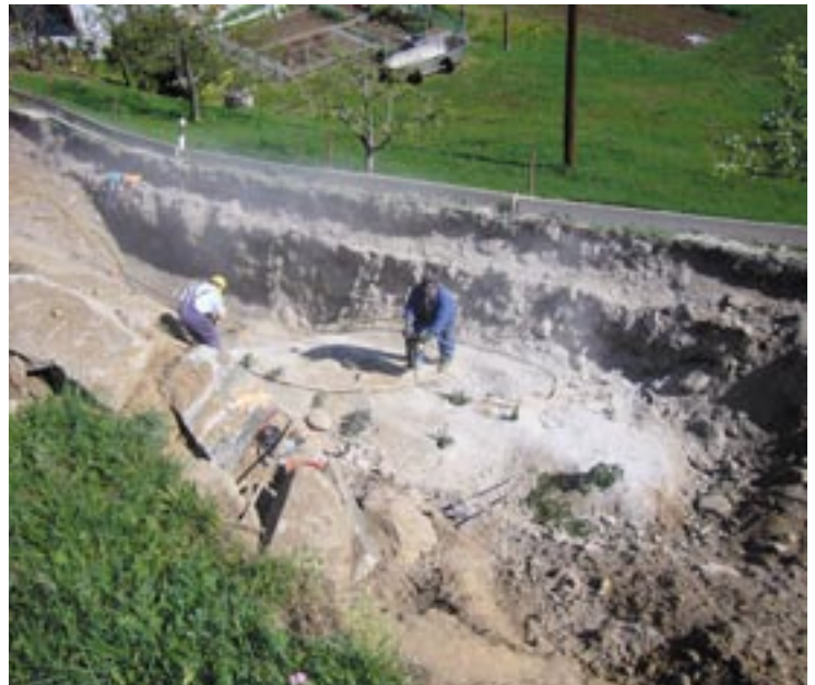
Nicht nur finanziell harte Brocken beim Kanalbau am Kraßweg
