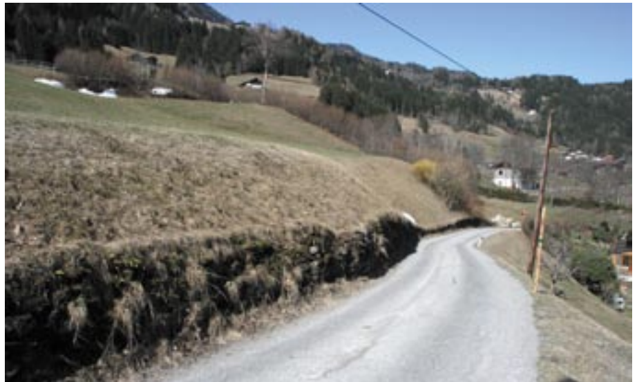
Die Sanierung der Straße beinhaltet natürlich auch die Sicherung der tal- und bergseitigen Böschungen, sowie die Verkabelung der Versorgungsleitungen.
