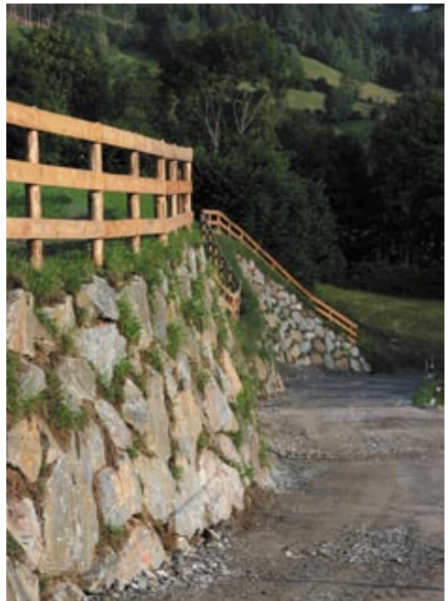
Eine neue Trockensteinmauer prägt nunmehr das Bild am Beginn des Kraßweges.
